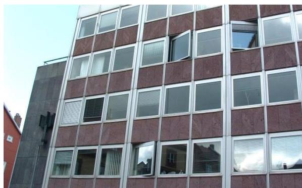
Fulda, ehemaliges Fernmeldeamt von Sepp Ruf fertiggestellt 1973. Natursteinplatten aus Michelnauer Schlackenagglomerat. Die Instandsetzung unter Verwendung des gleichen Natursteinmaterials wurde 2015 abgeschlossen (aus Beitrag Hehl, IFS-Bericht Nr. 53)
