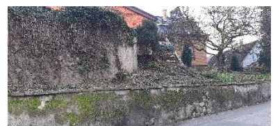
Fürth im Odenwald, Umfassungsmauer
