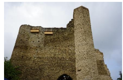
Wallrabenstein, Burg (saniert)
