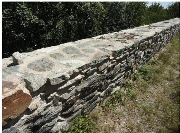
*Mauerkronenabschnitt saniert mit unterschiedlichen Mörtelrezepturen, Überreste der mustermäßig erfolgten Moosaussaat*
