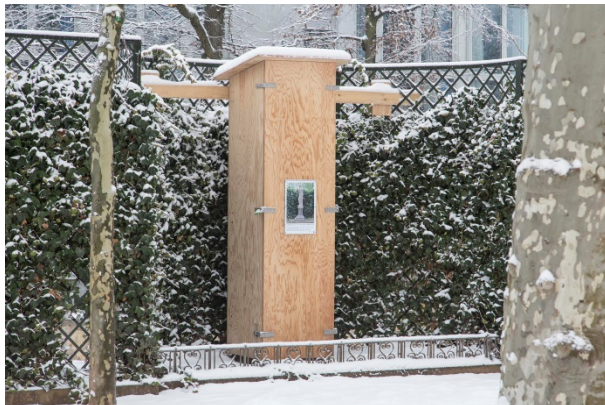
Darmstadt, Mathildenhöhe, Platanenhain. Wintereinhausung aus Holz um eine der sieben Wasserträgerinnen von Bernhard Hoetger, 1914. Die Skulpturen aus fränkischem Muschelkalk wurden 2012 restauriert und werden seitdem von Oktober bis März vor den klimatischen Einflüssen geschützt. (Foto: N. Heiss, 2013)
