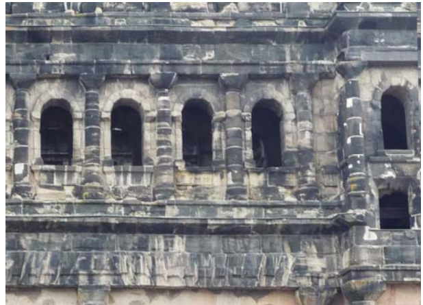
Heterogene Verschmutzungen an der Südfassade der Porta Nigra
