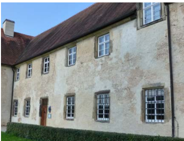
Altmorschen, Kloster Heydau, Südflügel, Südseite, Putzreparatur
