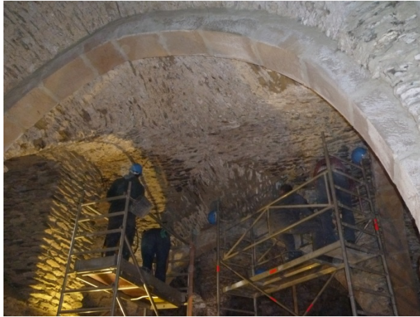
Burg Vianden, Gewölbekeller
