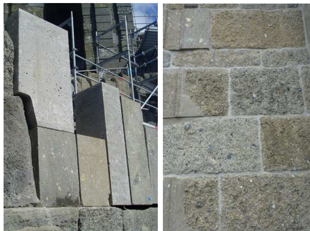
Links: Kunst-Tuffstein ersetzt teilweise die Nadelsteine an den Treppenaufgängen, hier im Bild fehlt noch die steinmetzmäßige Bearbeitung der Oberflächen.
