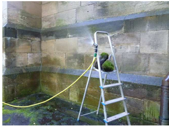
„Beregnungsversuch“ an der Stadtkirche in Sonneberg
