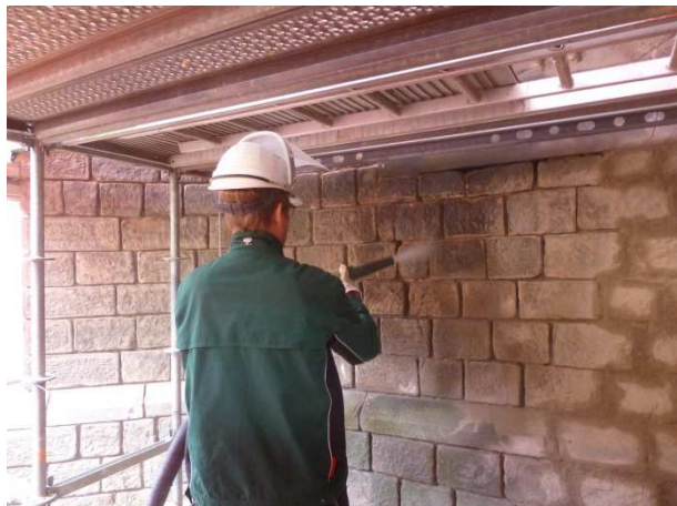
Anlegen einer Musterfläche zur Verfugung im Trockenspritzverfahren an der Kath. Pfarrkirche Herz-Jesu in Landsweiler-Reden
