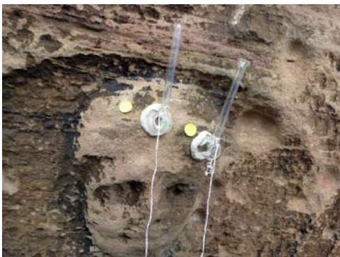
Igel (bei Trier), Igeler Säule (Römischer Grabpfeiler): Messung der Wasseraufnahme mittels Prüfröhrchen zur Bewertung der Hydrophobierung der Sandsteinelemente.
