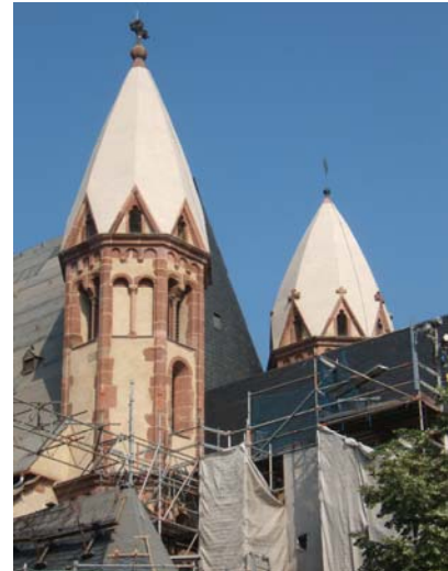
Frankfurt, Leonardskirche, Gelungene Instandsetzung der Turmdächer mit Spezial- mörteln
