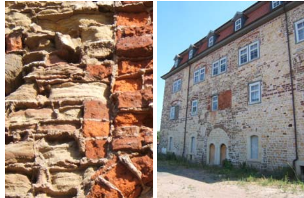
Mauerwerk mit historischen Gipsmörteln vor und nach der Instandsetzung mit modernen Gipsmörteln.
