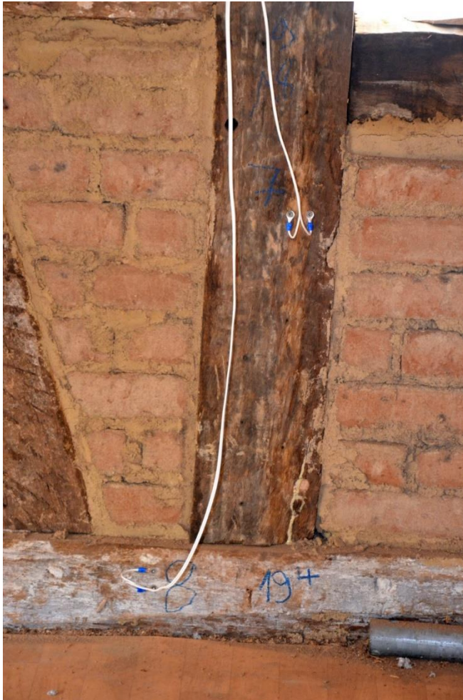
Platzierung von Feuchtemesspunkten in Form von Edelstahlschrauben zur Kontrolle der Holzfeuchte nach dem Verschließen der Fachwerkwände oder der Holzbalkendecken
